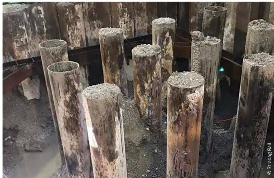
Projekt nötig war, um flexibel gleisgebunden einfahren zu können, und konnte Tiefen bis zum Ende des Bärseils (35 m) herstellen. Bei einer Pfahllänge von rund 24 m wurden die Stahlrohre mit 406 mm Durchmesser jeweils zweimal gestoßen und verschweißt.
