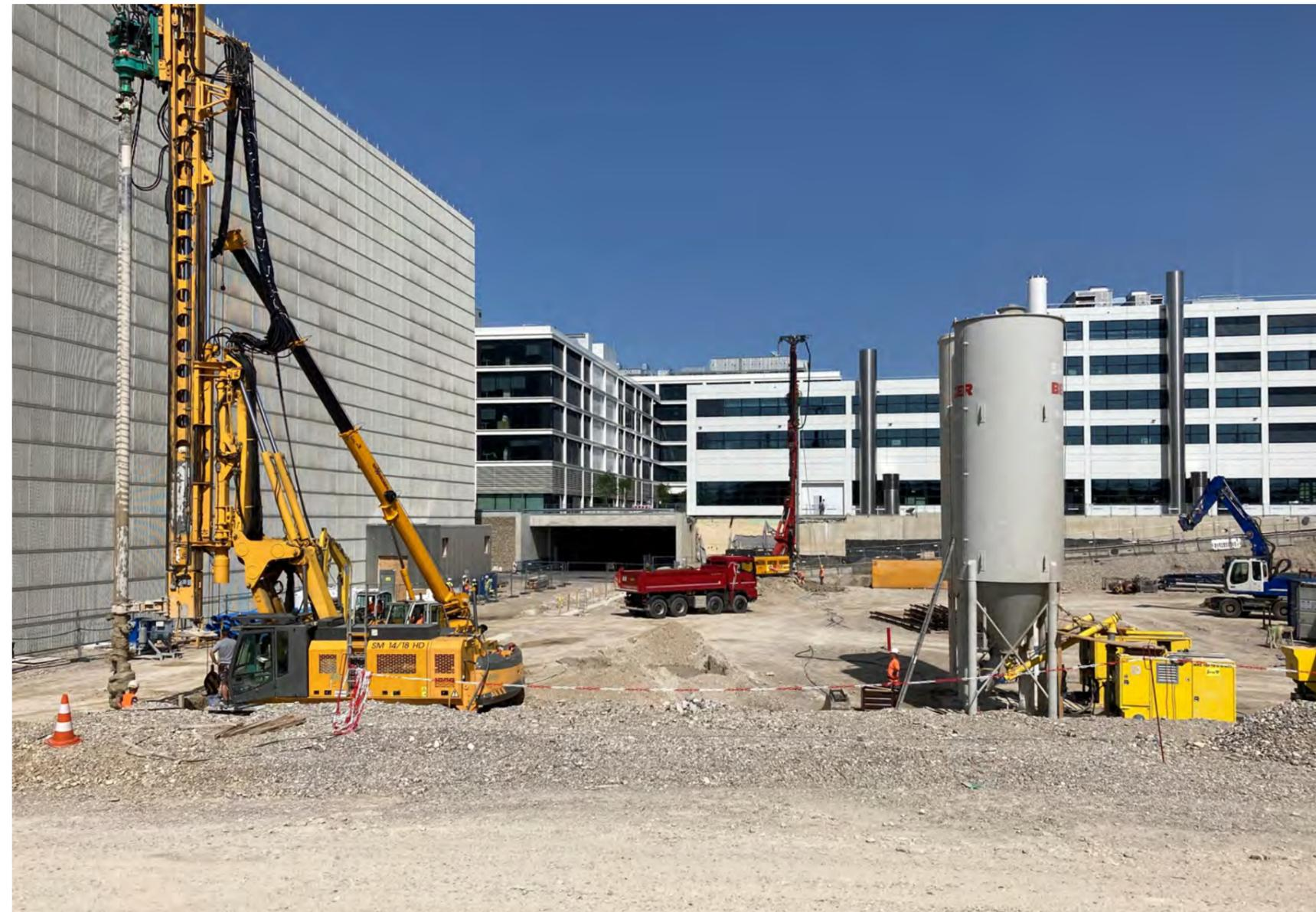
Spritzbetonausfachung hergestellt. 1.200 m temporäre Verpressanker sicherten die Baugrube und über eine geschlossene Wasserhaltung wurde das Eindringen von Grundwasser verhindert.
