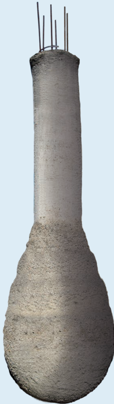
Ausgerammter Fuß des FRANKIPFAHLES NG®
